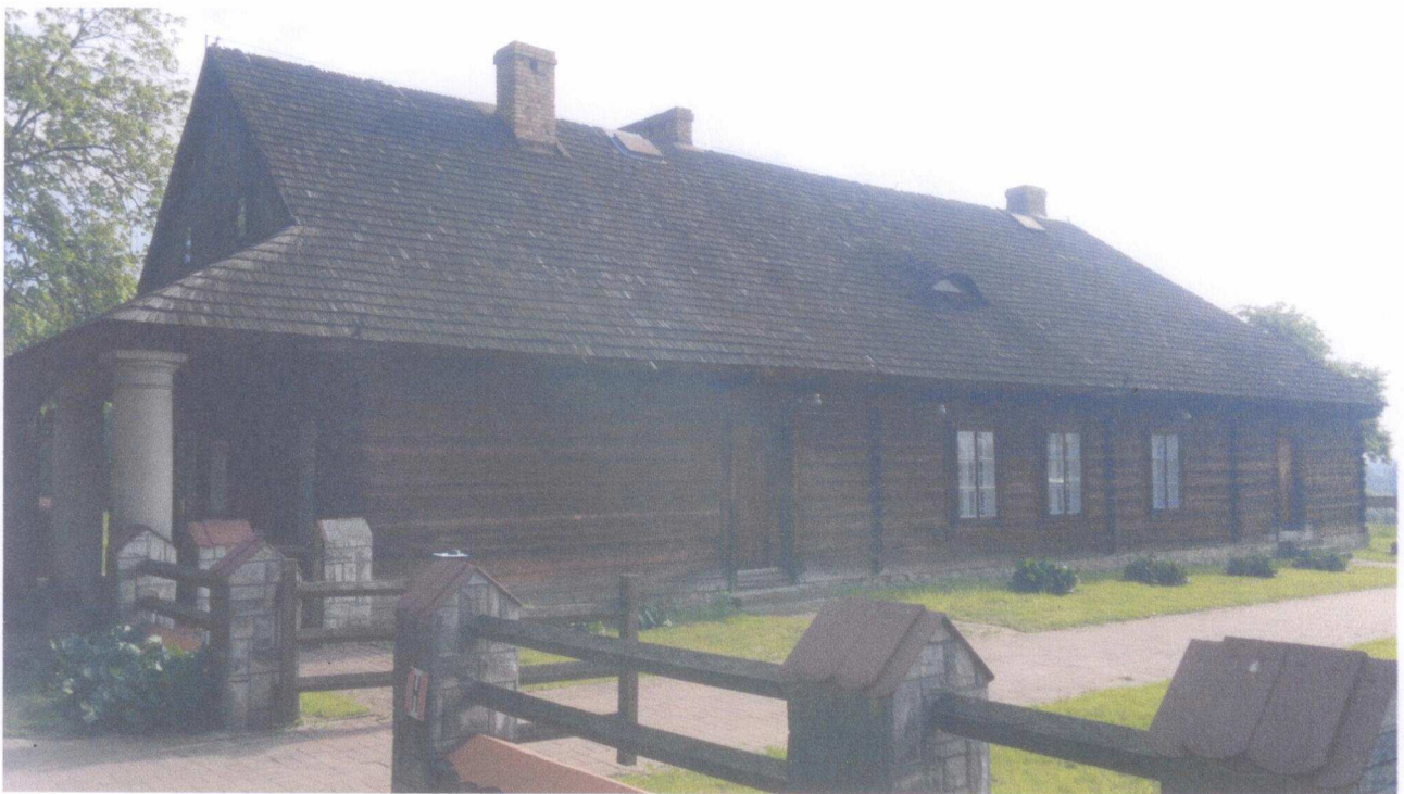
widok od strony południowej
